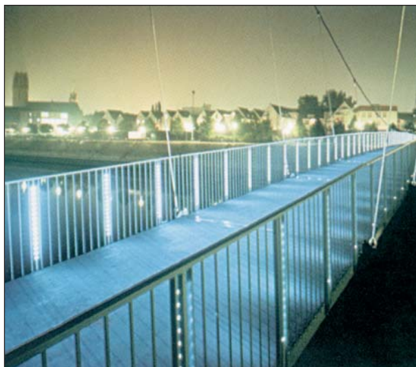
Мост в Дуйсбурге, освещенный колоннами светодиодных светильников (Compound Semiconductors. 2000. V.6. №2. P.40).
